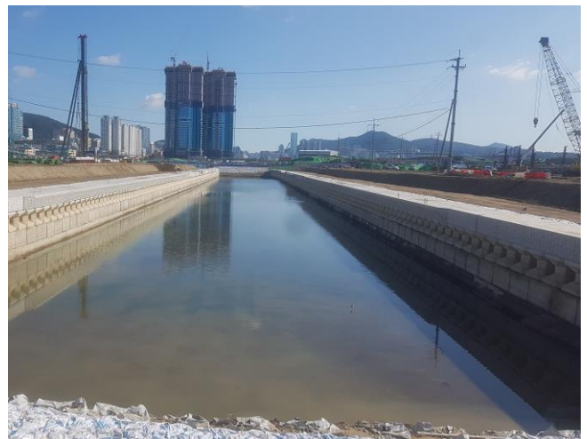
시공 후 육측 전경
