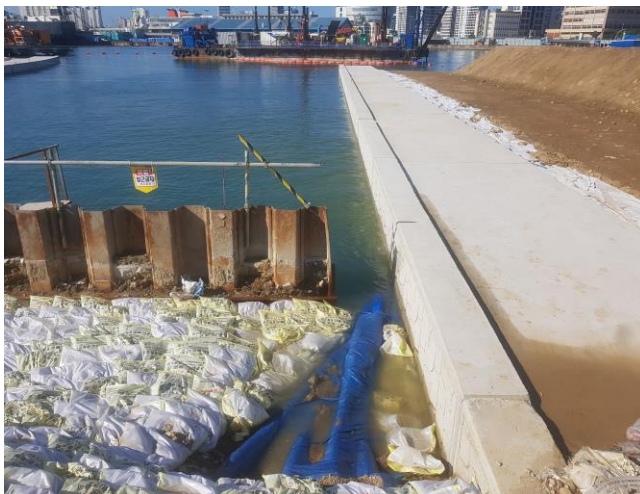
시공 후 해측 전경
