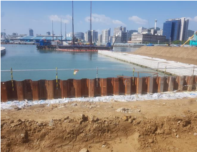
시공 전 해측 전경
